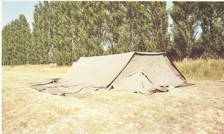
Fig. 20 - Vue de l'entoilage complet disposé sur l'armature
