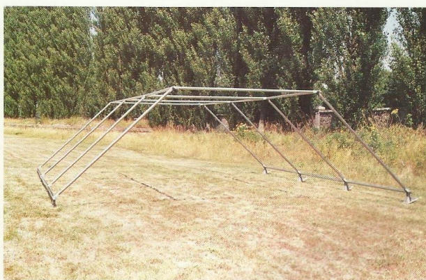
Fig. 16 - Vue d'ensemble de l'armature comportant quatre poteaux, les huit arbalétriers, les deux sablières et la faîtière
