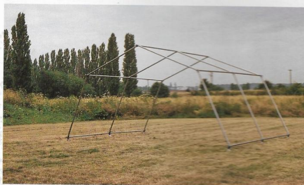
Fig. 4 - Armature de la tente 2 travées
