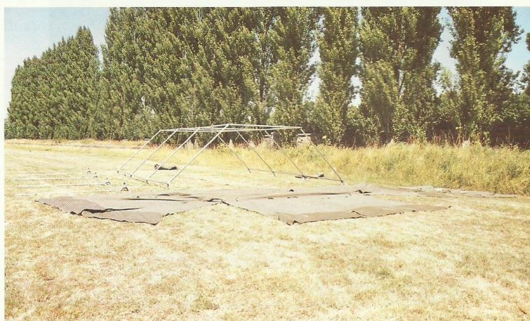
Fig. 17 - Vue de l'entoilage disposé à plat, prêt à être posé sur l'armature
