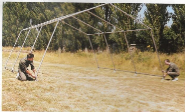
Fig. 3 - Armature de la tente 3 travées
